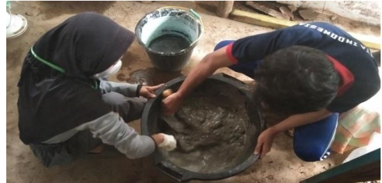
Gambar 4. Pembuatan adonan semen
